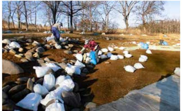
写真4-7 雪害対策として石の崩落を防止する緩衝材を配置
