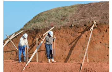
写真4-3 新原・奴山古墳群 25号墳墳丘の崩落部の復旧作業(2014年)
