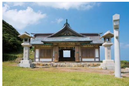
写真 2-a-13 沖津宮遙拝所社殿（正面）
